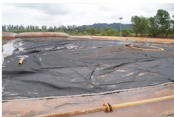
Раскатка геотуб Миатубы® поверх геомембраны перед заполнением
