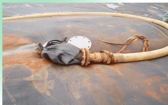
Стыковка гибкого шланга с питающим портом геотубы
