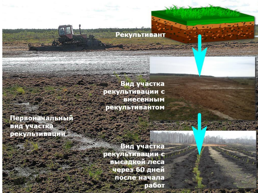
Процесс рекультивации земель
