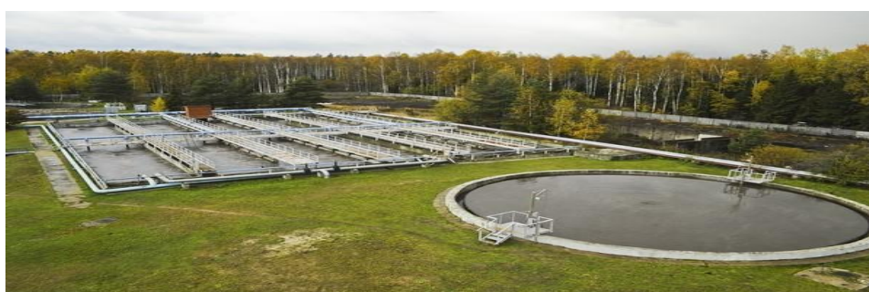
Очистные сооружения для поселка с применением эйхорнии, ТСС и органического флокулянта
