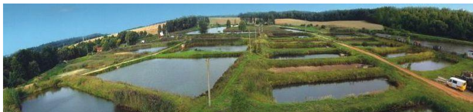
Комплекс прудов фермерского хозяйства подготовленный для очистки сточных вод эйхорнией и ТСС
