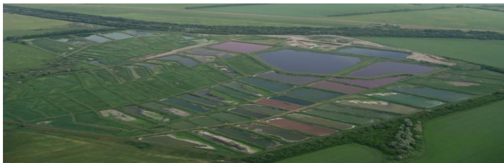
Чеково-стационарный комплекс очистки сточно-фекальных вод крупного населенного пункта
