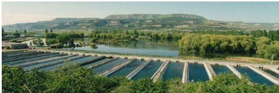
Комплекс очистных прудов с применением эйхорнии и ТСС на проточных каналах и органического коагулянта на доочистку воды
