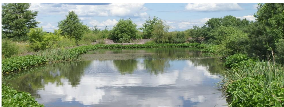
Один из прудов комплекса очистки сточных и фекальных вод эйхорнией
