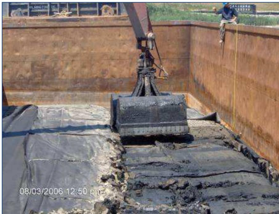
За 45 дней концентрация тв.осадка достигла 67%.. Осадки были удалены из баржи экскаватором, перевезены и захоронены на полигон в Нью Джерси
