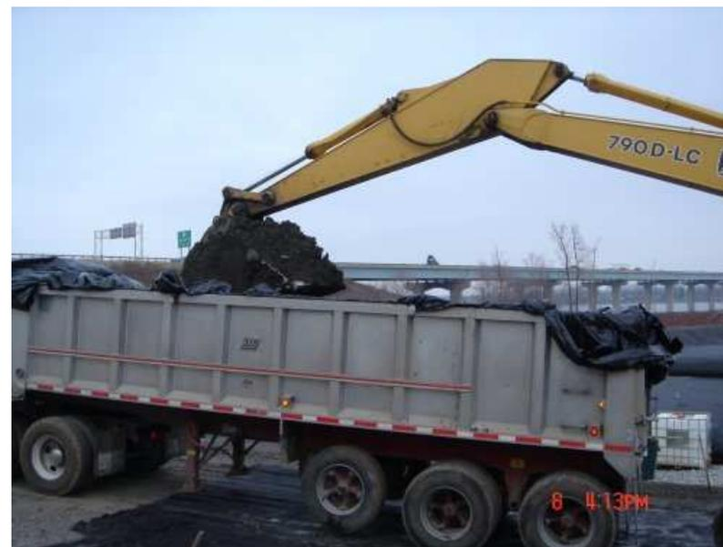
По завершении процесса обезвоживания, контейнеры Geotube® вскрывают, осадок грузят на самосвалы и вывозят на полигон утилизации
