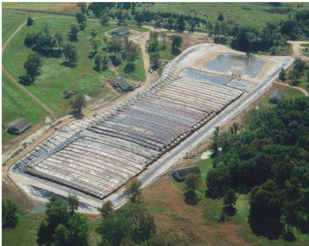
**Решение:** 8.500 метров Геотруб с периметром 13,7 м (2001) и 3.200 метров с 18,3 периметром (2006) уложено для обезвоживания более 110.000 м<sup>3</sup> загрязненных донных отложений.
