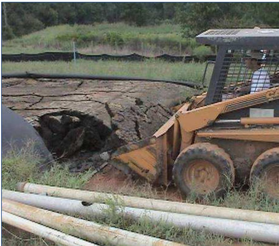
Твердый осадок из контейнеров Geotube® небольшого размера может быть удален фронтальным погрузчиком или трактором с навесным ковшом.
