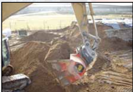
Стабилизация фундаментного слоя
